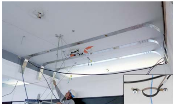
Figura 11. Reparación de una losa en un edificio escolar en Nieppe, Lille, Francia, mediante láminas de AMF para reducir el ancho de las grietas de flexión 44 .
