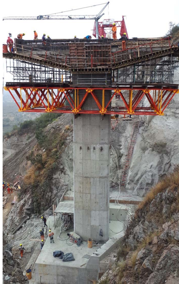
Figura 4. Vista general de las pilas de gran altura del Viaducto 1
