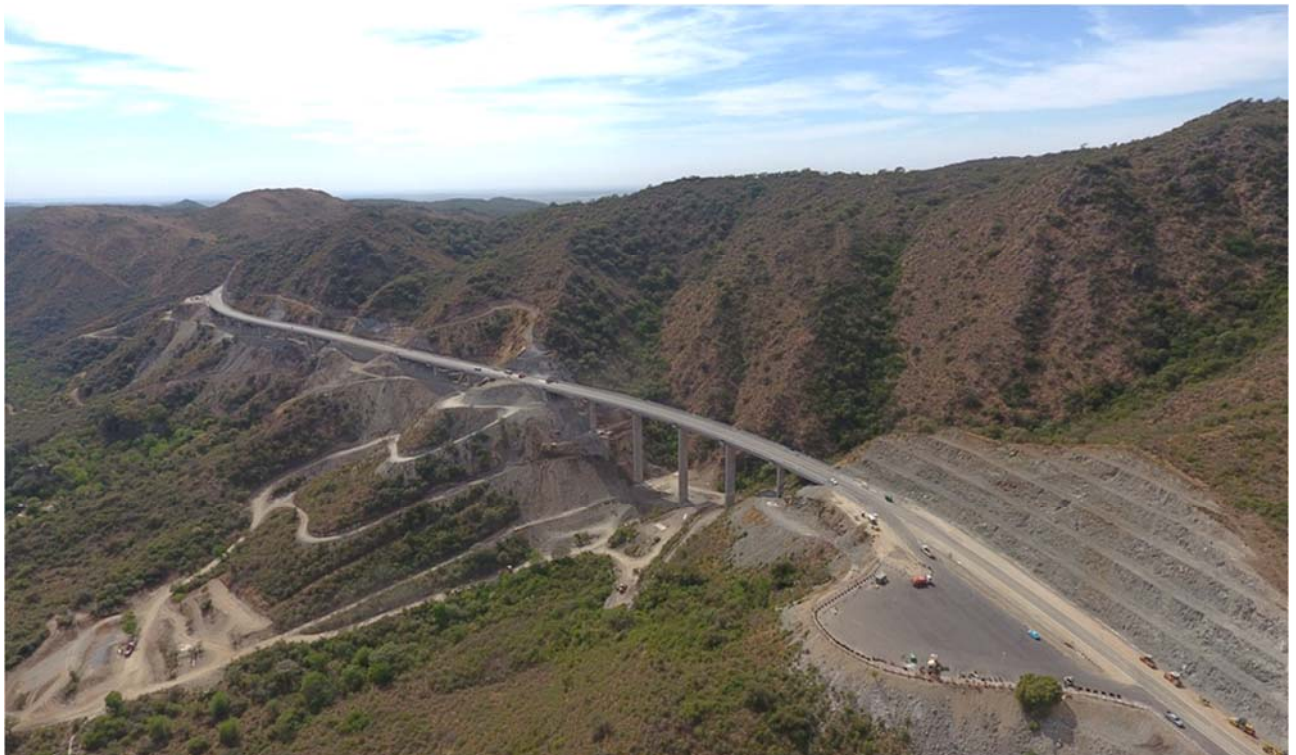
Figura 1. Vista general de los Viaductos Carreteros de las Altas Cumbres
