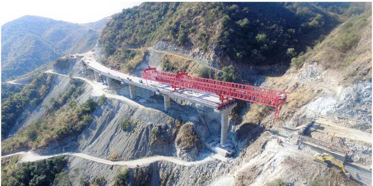
Figura 7. Vista de la viga de lanzamiento durante el montaje de vigas en Viaducto 1
