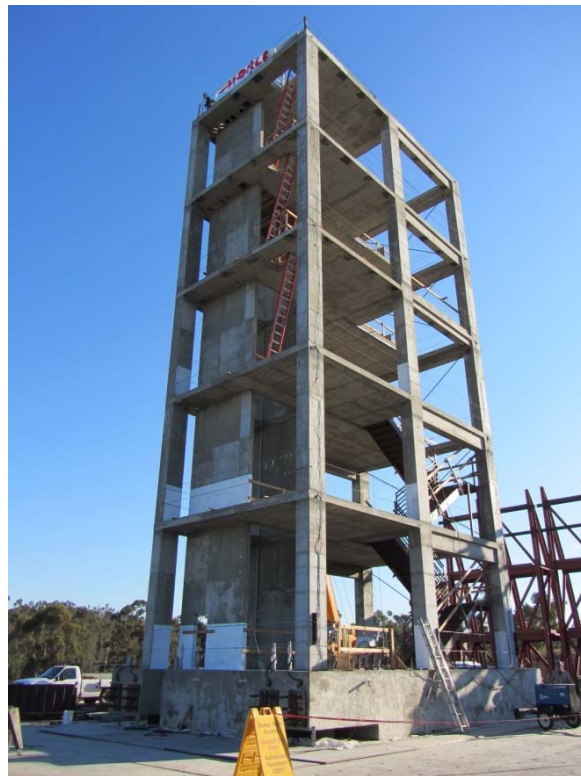
Figura 5. Edificación de cinco niveles construido para investigación en el campus de la Universidad de California, sede San Diego
