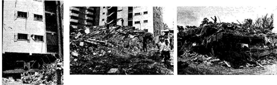
Figura 7. Fotos daños en paredes y torre colapsada. [4]
