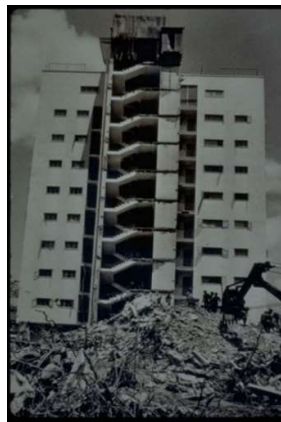
Figura 2. Edificio Palace Corvin, torre este derrumbada y torre oeste en pie. [4]
