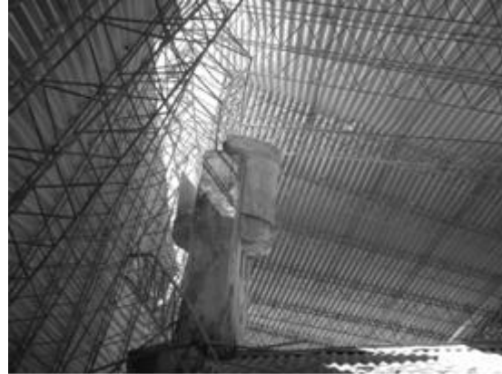
Fig. 10 Detalle de estructuras livianas hechas con barras de acero. Izquierda: Columnas que soportan una cubierta de 35 m de luz; derecha: pórticos colapsados de una cubierta aislada sin paredes laterales de 20 m x 45 m.
