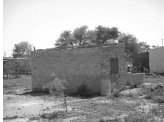
Fig. 9 Estos son ejemplos típicos de estructuras Clase 2A. Ambas estructuras perdieron el techo durante la tormenta descrita en la sección 4.5
