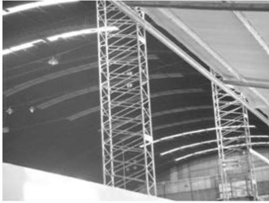
Fig. 10 Detalle de estructuras livianas hechas con barras de acero. Izquierda: Columnas que soportan una cubierta de 35 m de luz; derecha: pórticos colapsados de una cubierta aislada sin paredes laterales de 20 m x 45 m.
