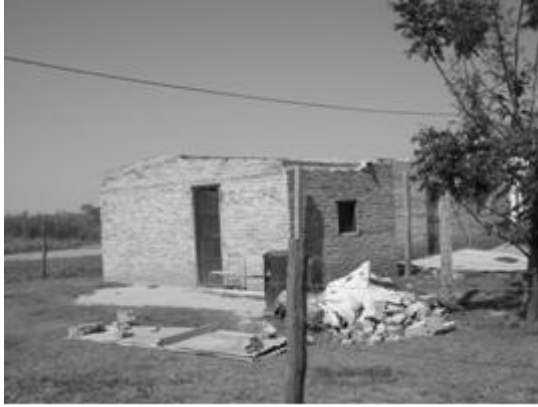
Fig. 9 Estos son ejemplos típicos de estructuras Clase 2A. Ambas estructuras perdieron el techo durante la tormenta descrita en la sección 4.5
