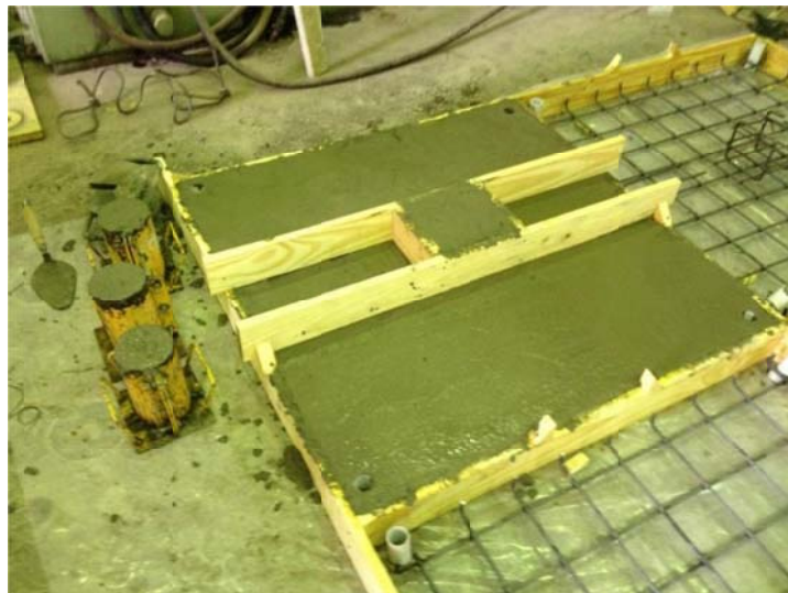
Figura 2. Vista de Armadura y hormigonado
