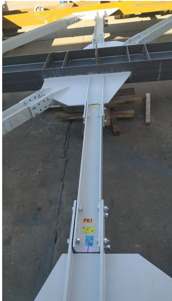
Figura 14. Pre montaje de viga reticulada
