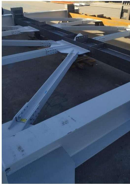
Figura 13. Pre montaje de viga reticulada en fábrica
