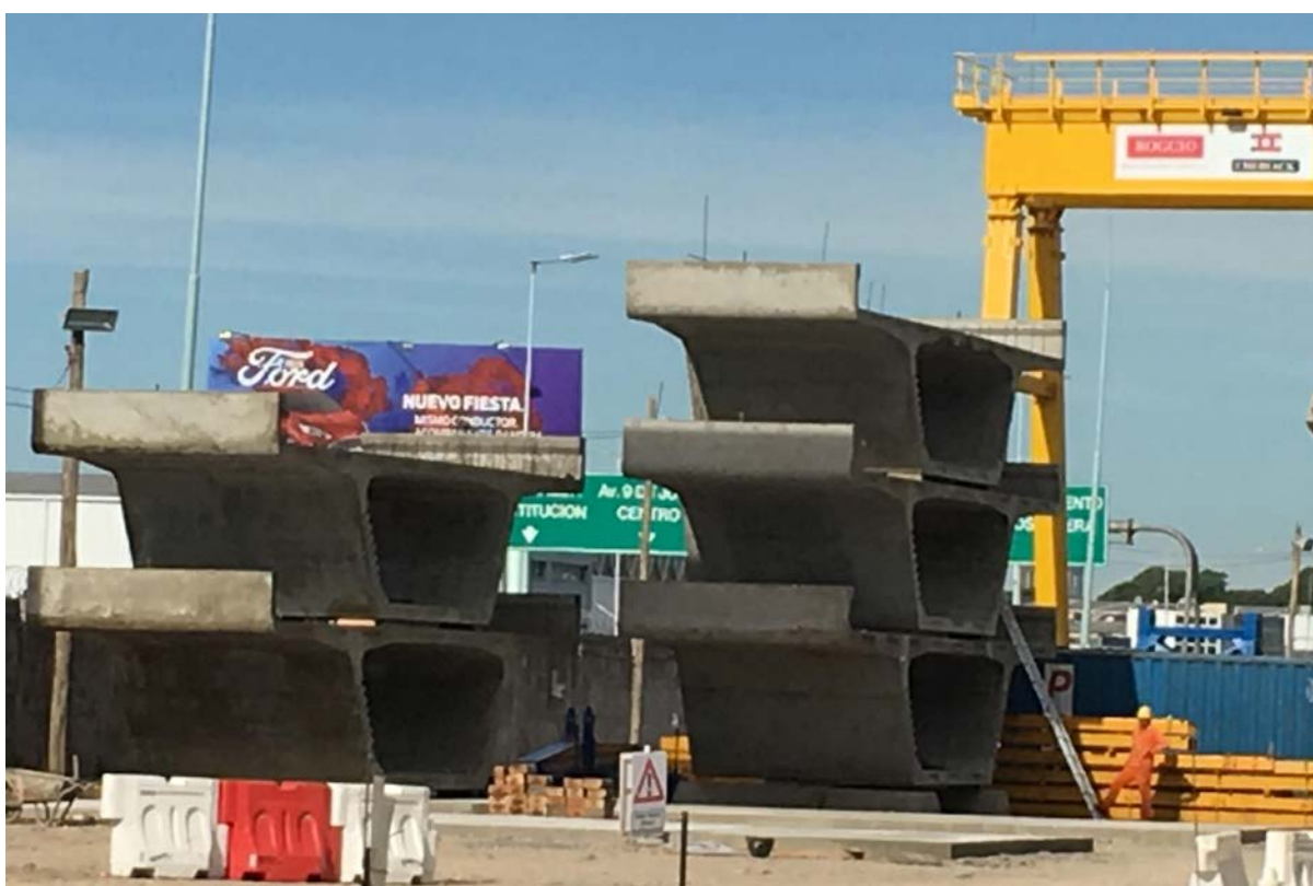
Figura 23: Acopio de dovelas en planta de prefabricación.
