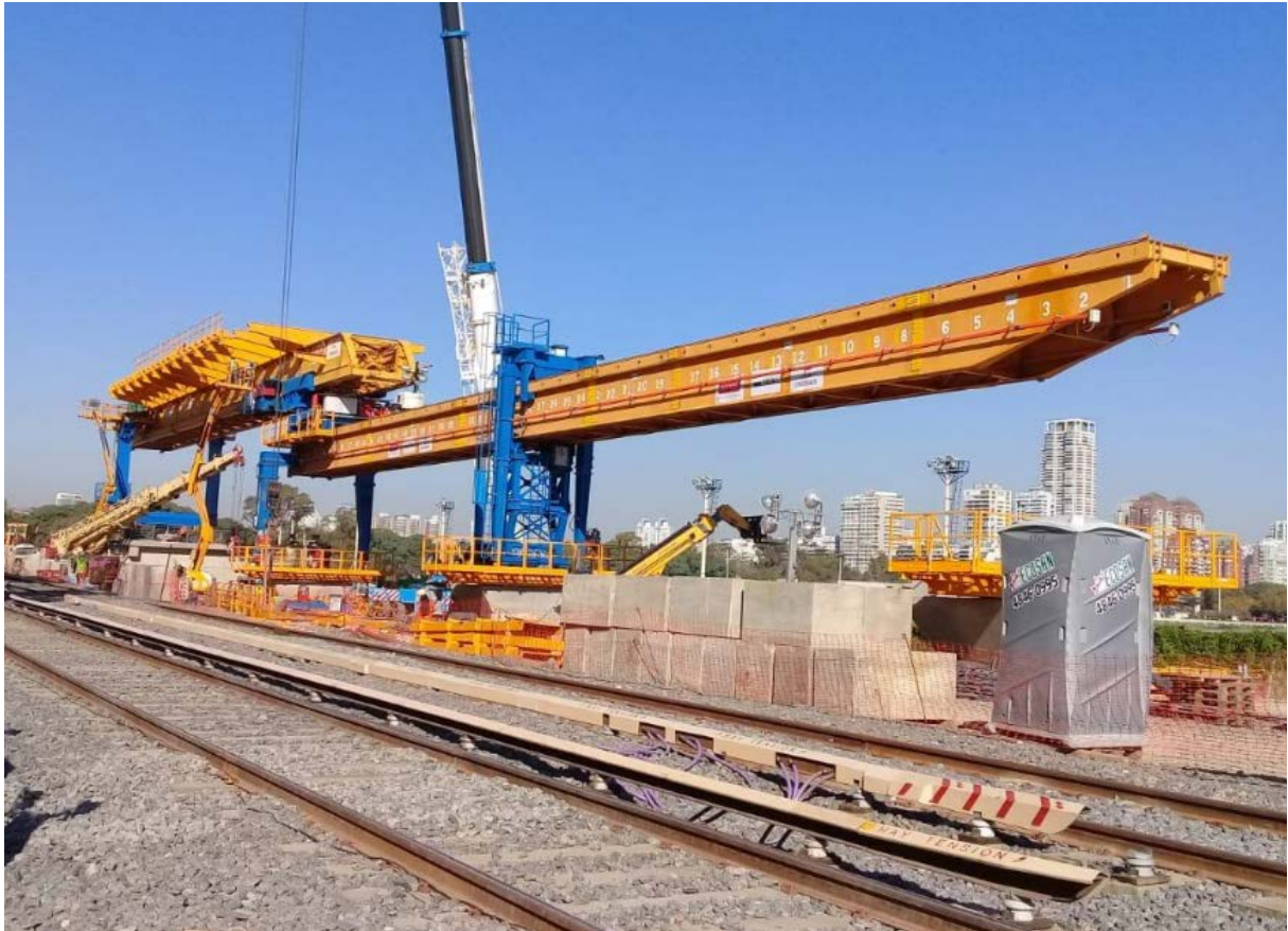
Figura 24: Viga lanzadora.
