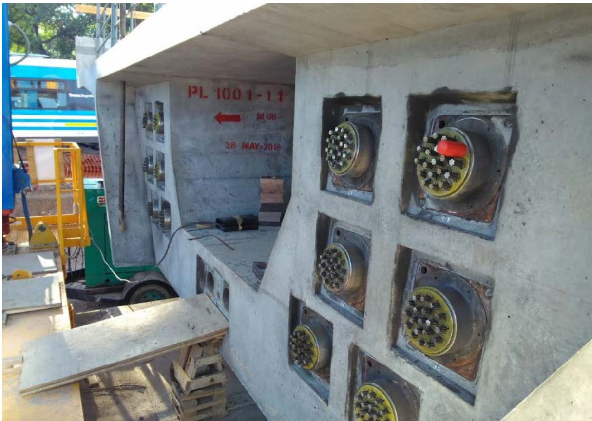
Figura 27: Dovela de pila. Diafragma extremo de anclaje de cables.
