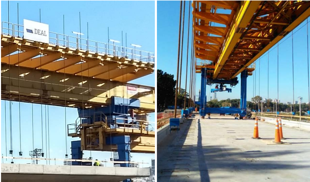
Figura 28: Viga montada y tesada. Dovelas descolgadas de la viga lanzadora.
