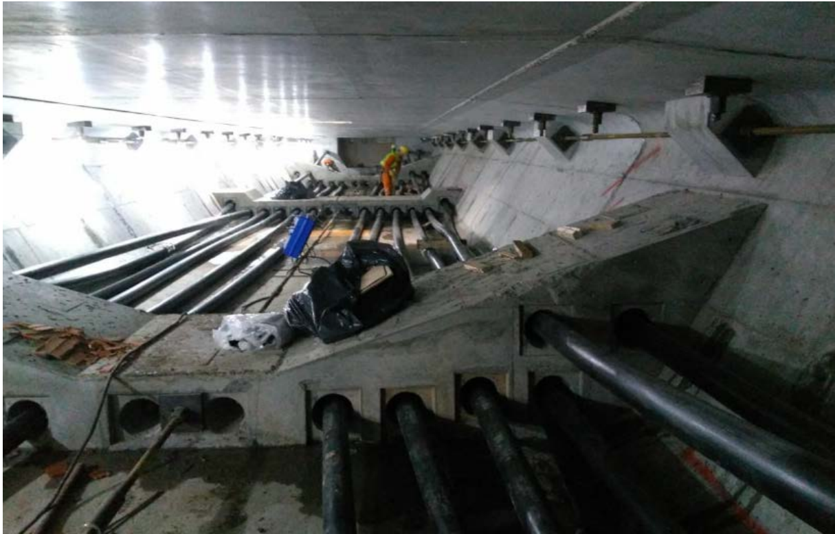
Figura 26: Desviadores laterales y central.
