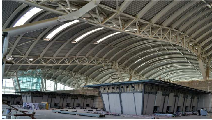
Figura 8. Cubierta zona procesador
