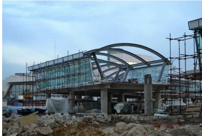
Figura 6. Pasarela de conexión
