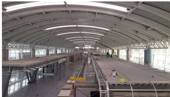
Figura 9. Cubierta zona dique
