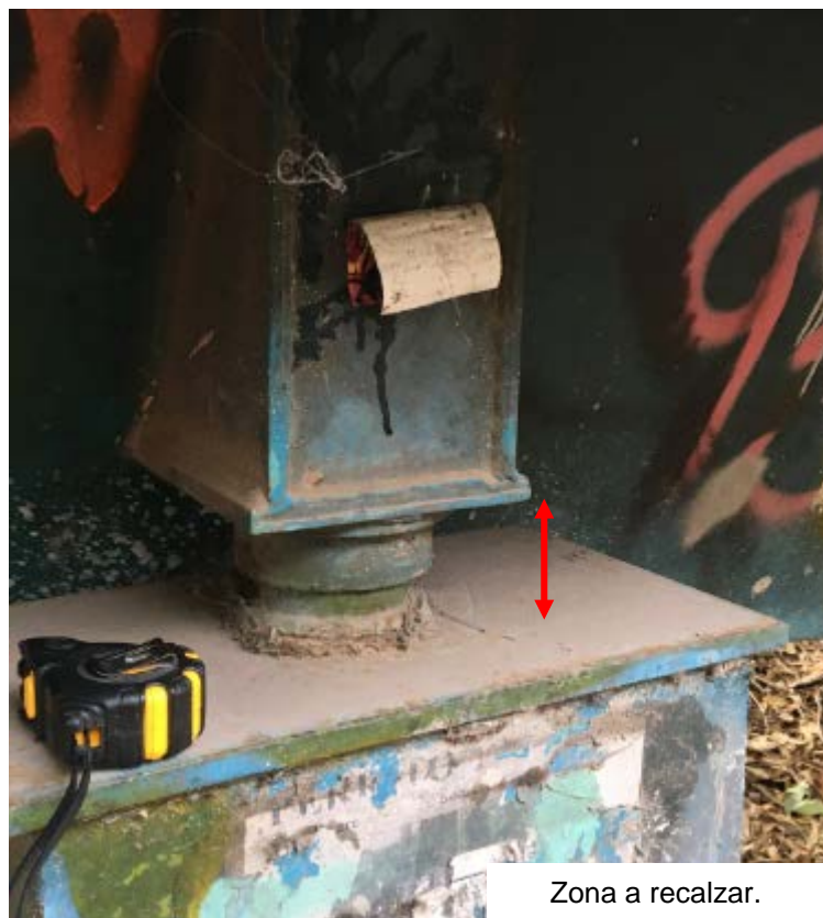
Figura 13. Detalle típico de apoyos.
