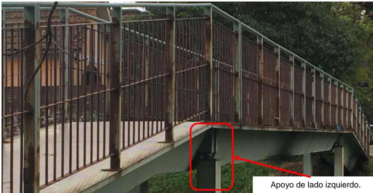
Figura 12. Apoyo izquierdo del tramo central.
