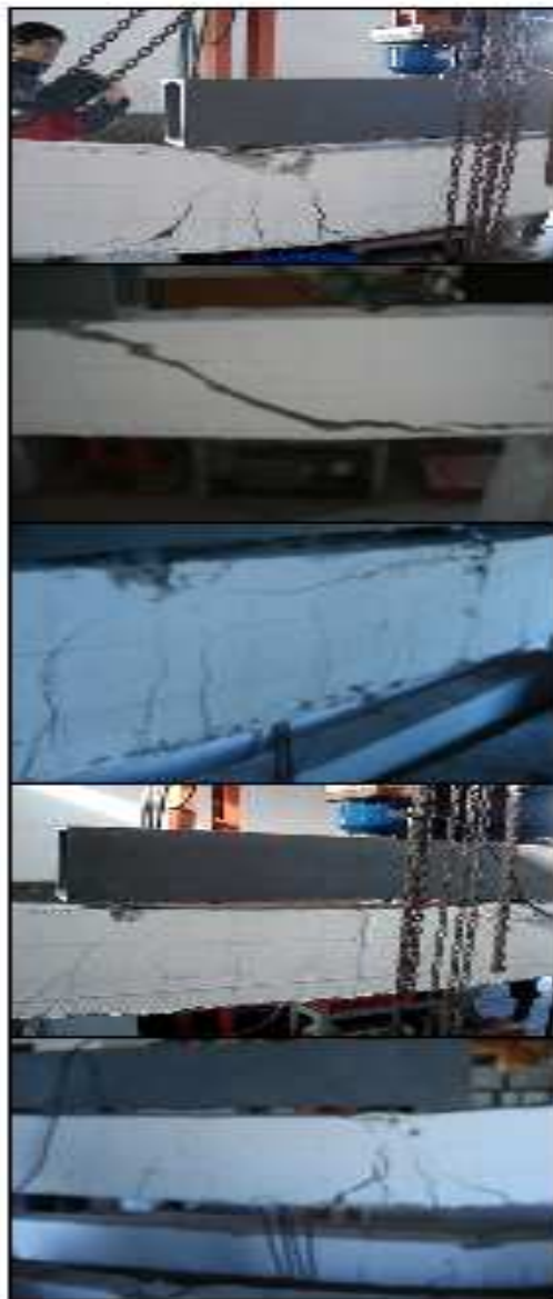
Figura 15- Registro fotográfico para las vigas de la Serie B, correspondiente a la carga de rotura.
