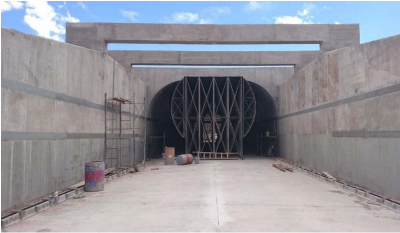
Figura 19. – Muros y pórticos Entrada Túnel
