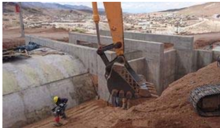
Figura 18. – Muros y tímpano Entrada Túnel
