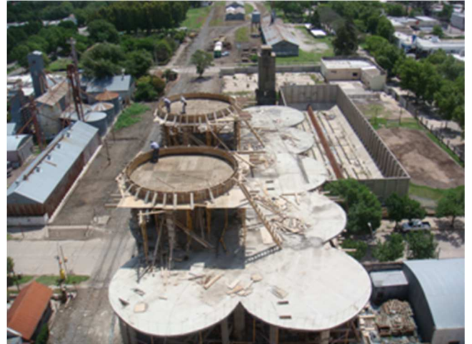
Figura 25. Losa final de rigidizacion y niveles nuevos
