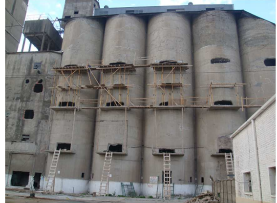
Figura 21. aperturas pequeñas para hormigon losas internas y voladizos de 1,30 m
