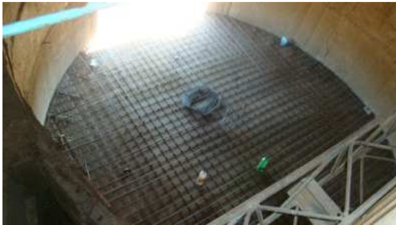
Figura 26. Losa de entrepisos
