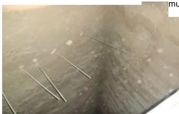
Figura 28 esperas para lasas de entresilos
