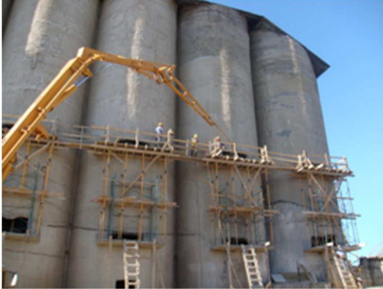
Figura 20. Voladizos progresivos que se apuntalan desde un nivel inferior
