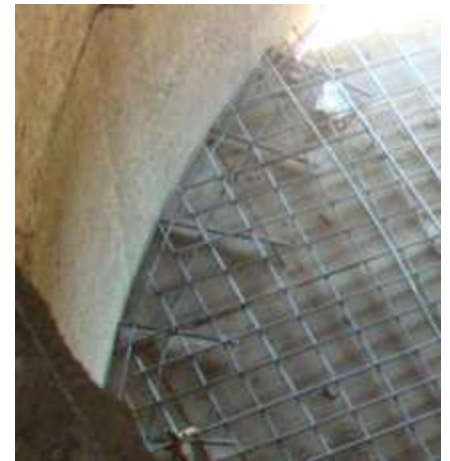
Figura 27, conexión lasas con muros de silos
