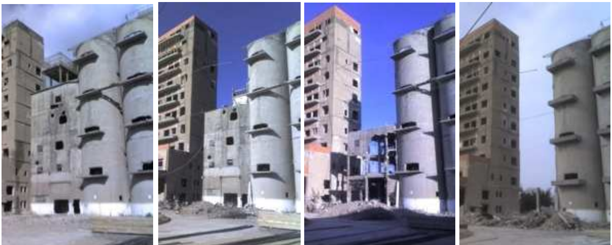
Figura 23- proceso de demolicion de sector Noria
