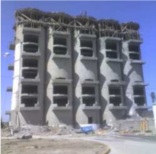
Figura 24. Apertura final de vanos luego de rigidizar las losas
