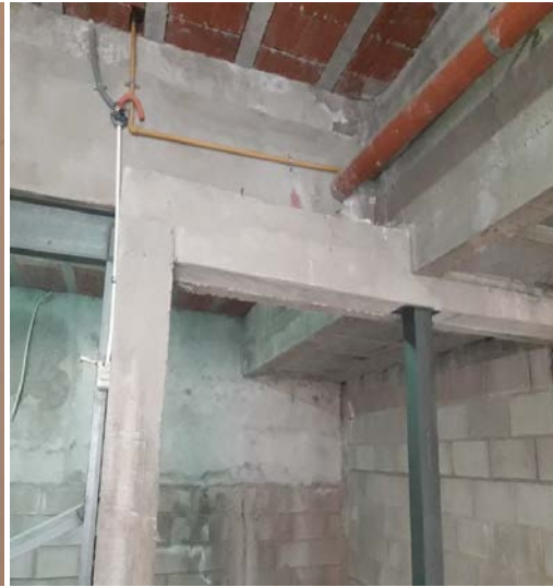
Figura N°5: Refuerzos en la estructura original, columnas y vigas adicionales
