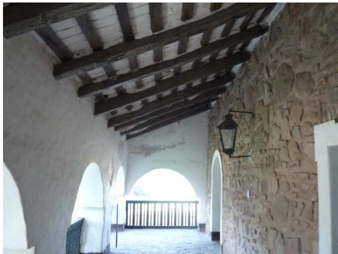
Fig. 11. Estructura de Cubierta sobre Galería Sur en planta alta (lateral de iglesia)
