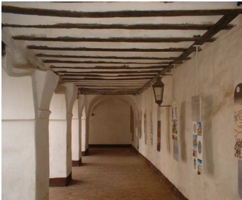
Figs. 3 y 4. Entramado horizontal (Forjado de entrevigado cuajado).
