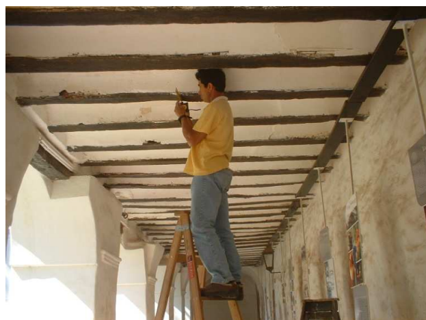
Fig. 7. Medición de flechas de las vigas de madera
