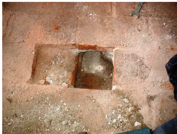
Fig.5. Calicata realizada en el nivel superior de la galería
