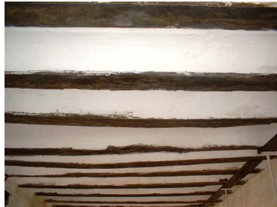
Figs. 3 y 4. Entramado horizontal (Forjado de entrevigado cuajado).
