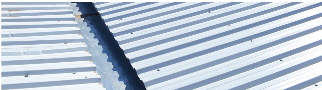
Figura 2. Tornillos autorroscantes colocados en el valle del plegado de la chapa
