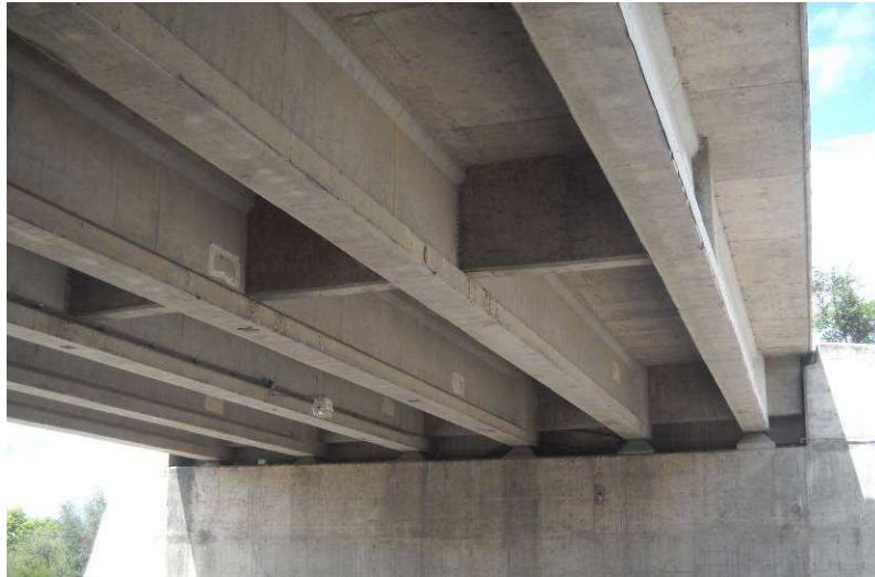
Figura 8: Estructura real del Puente UNSa Norte vista desde el plano inferior
