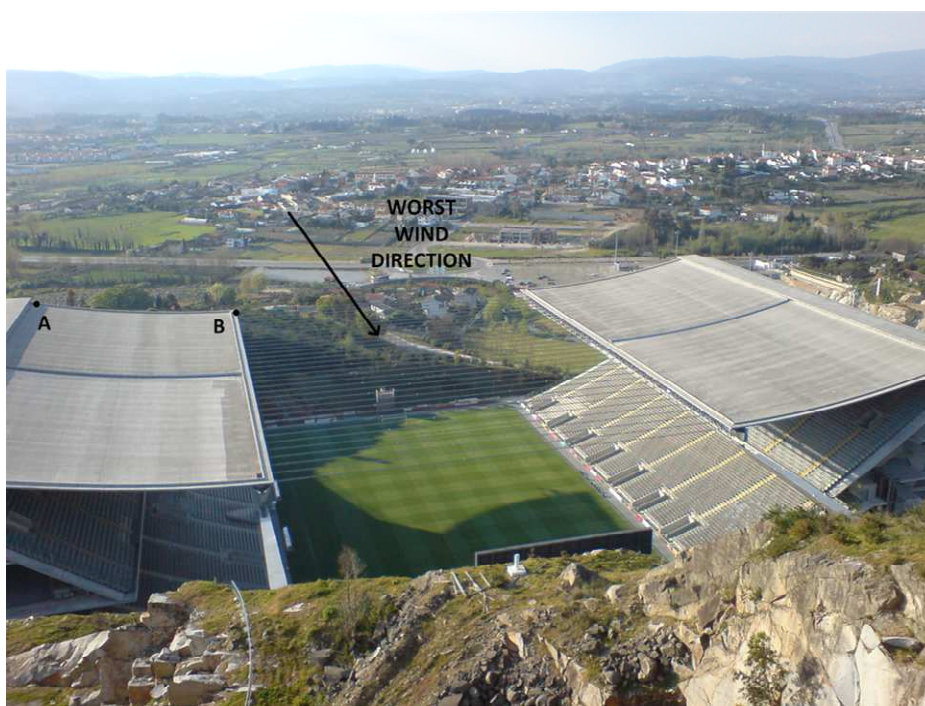
Fig. 9 Cubierta del estadio de Braga (Portugal)
