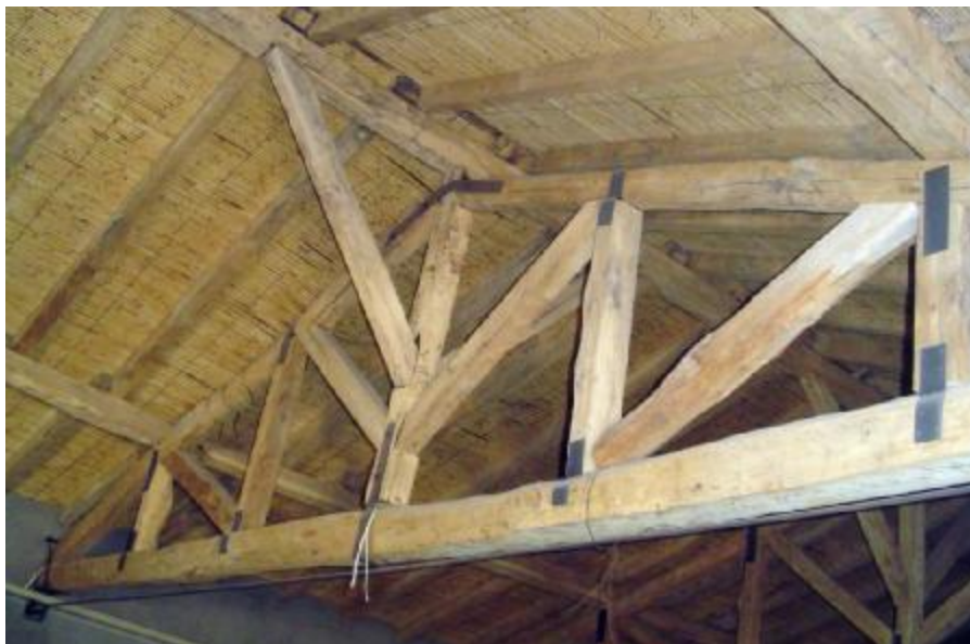
Figura 8. Vista de la viga reticulada luego de la rehabilitación.
