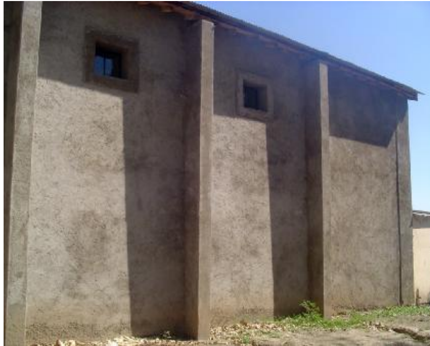
Figura 13. Vista del muro Este luego de la reparación.
