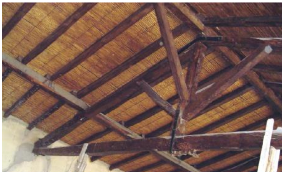
Figura 3. Vista de la estructura de techo antes de la rehabilitación.
