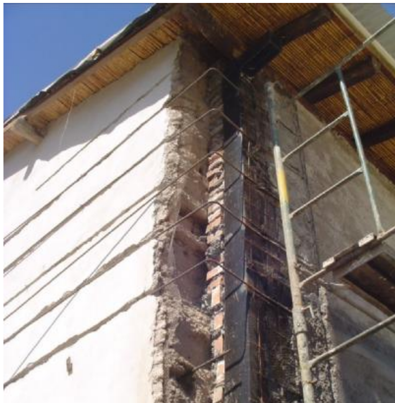
Figura 15. Vista del encuentro de los muros Norte y Oeste.
