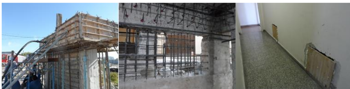
Figura 20 – Ensayo de hormigonado, refuerzo muros y eliminación de junta sísmica.
