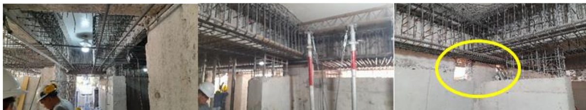
Figura 19 – Armado VC, en el círculo columna a ser cortada y espacio para aislador.
