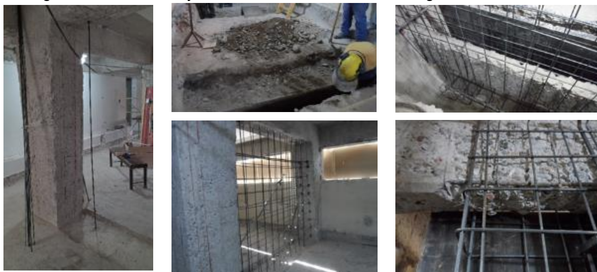
Figura 18 – Demolición albañilería, ejecución de fundaciones y muros de h° armado Luego se procedió al armado de las VC, los espacios eran sumamente reducidos para el personal. La tarea era muy delicada pues se realizaba el perforado de vigas, sin
