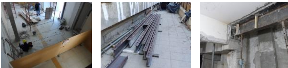
Figura 26 – Refuerzo juntas. Perforado de losa e inst. vigas con pernos nelson.
