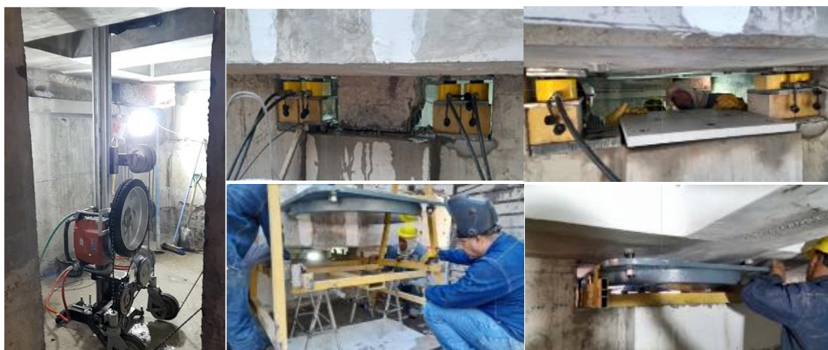
Figura 22 – Equipo de corte y proceso de instalación del aislador
