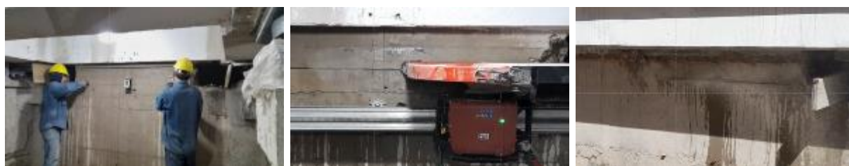
Figura 25 – Procedimiento de corte de muros.
