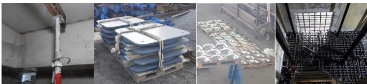
Figura 21 – Hormigonado de vigas, fabricación aisladores y armado losa ascensor.
