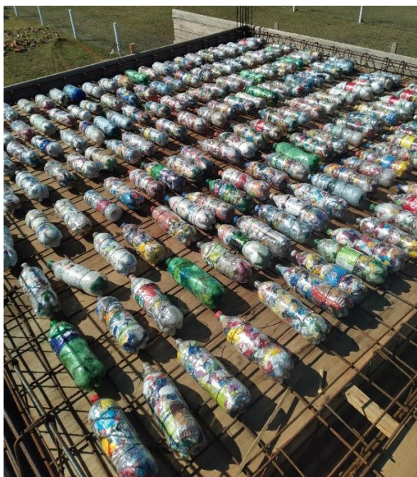
Figura 11. Foto de losa antes de hormigonar
