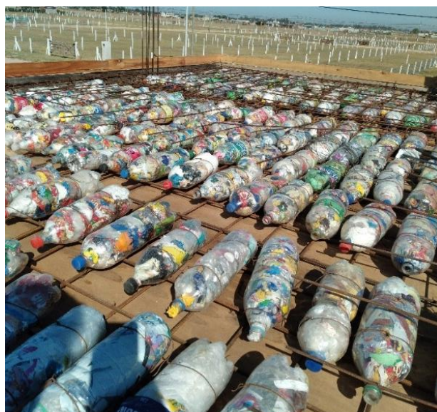
Figura 12. Foto de losa antes de hormigonar
