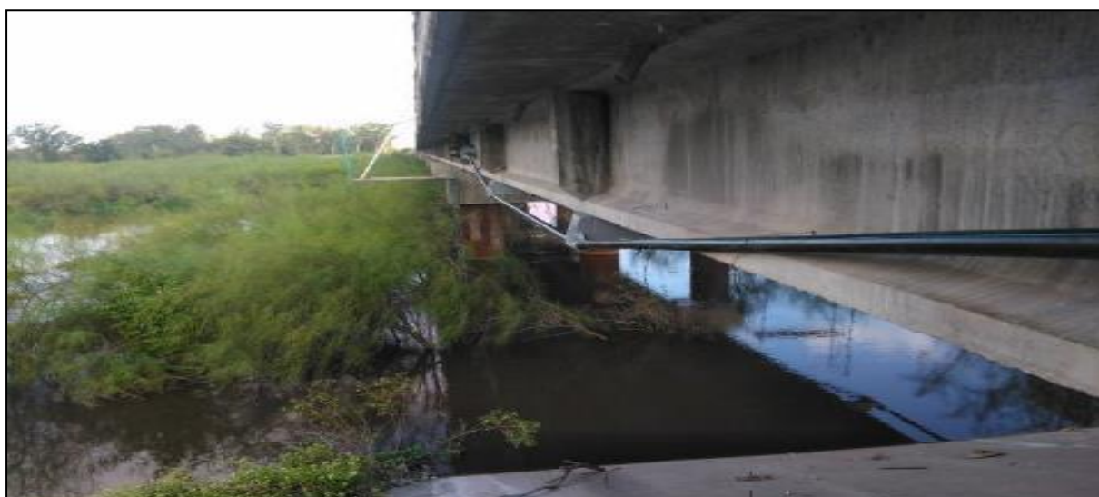
Figura 40. Vista Norte de los cables ya tesados
