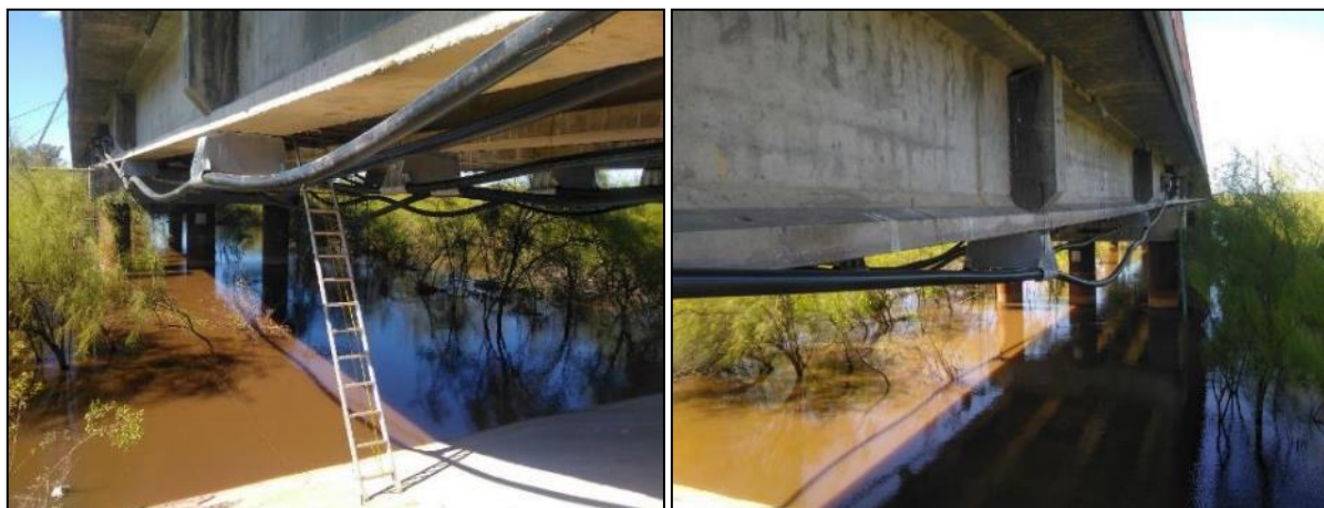
Figuras 38-39. Vista de tensores colocados no tesados
