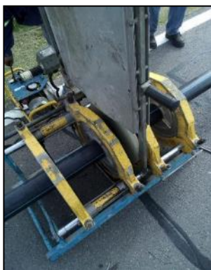
Figura 31. Unión de las vainas de PEAD
