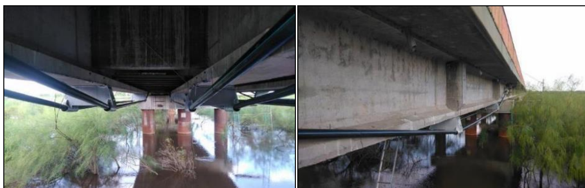
Figura 41-42. Vista inferior y sur de los cables tesados
