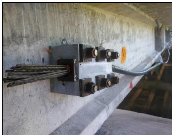
Figura 34. Extremo de cable (12 cordones)
