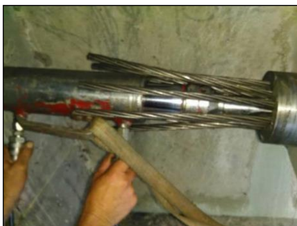
Figura 37. Tesado unifilar del cable
