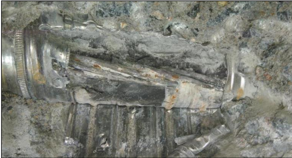
Figura 18. En Viga 1 – Auscultación tensor 1 – centro de tramo
