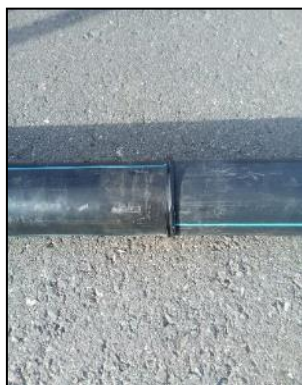
Figura 31. Unión de las vainas de PEAD
