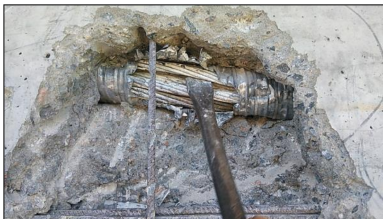
Figura 11. En Viga 1 - Tensor 4 lado estribo
