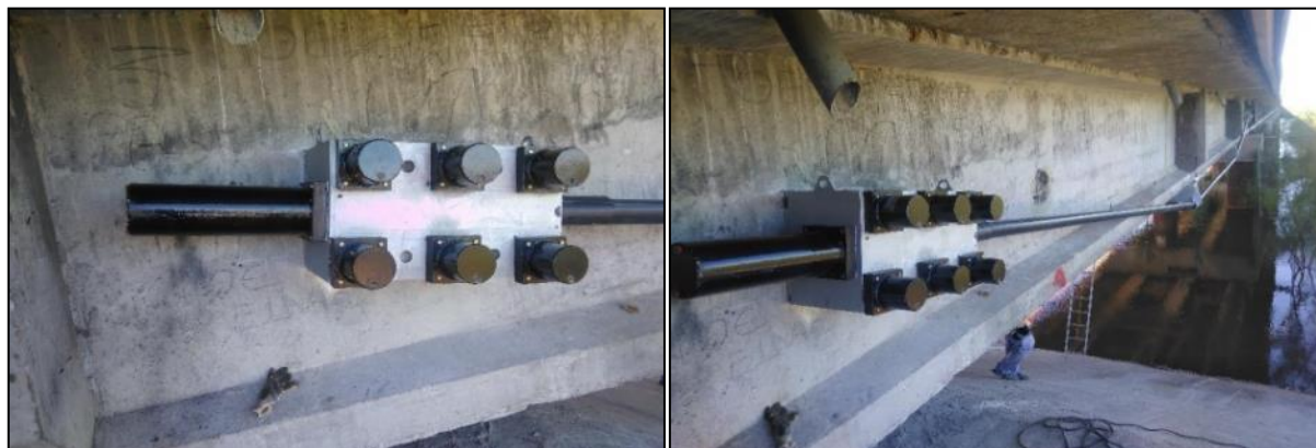
Figura 43-44. Anclaje c/ capots de protección de barras transversales y cordones colocados
