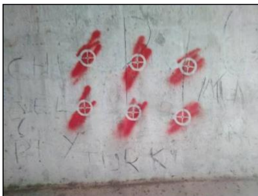
Figura 25. Replanteo de perforaciones
