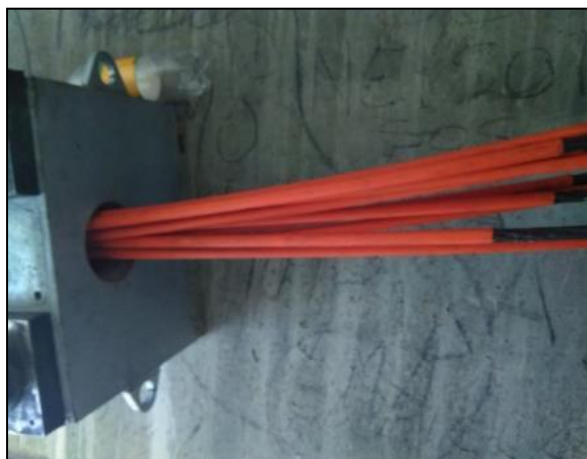
Figura 33. Enhebrado los cordones envainados
