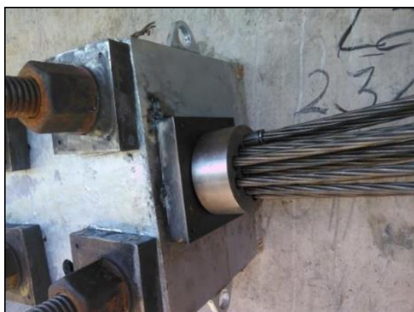
Figura 36. Bloque de anclaje y cuñas colocadas
