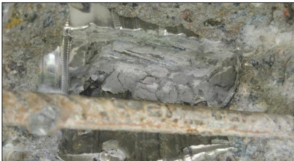
Figura 20. En Viga 1 – Auscultación tensor 3 – centro de tramo
