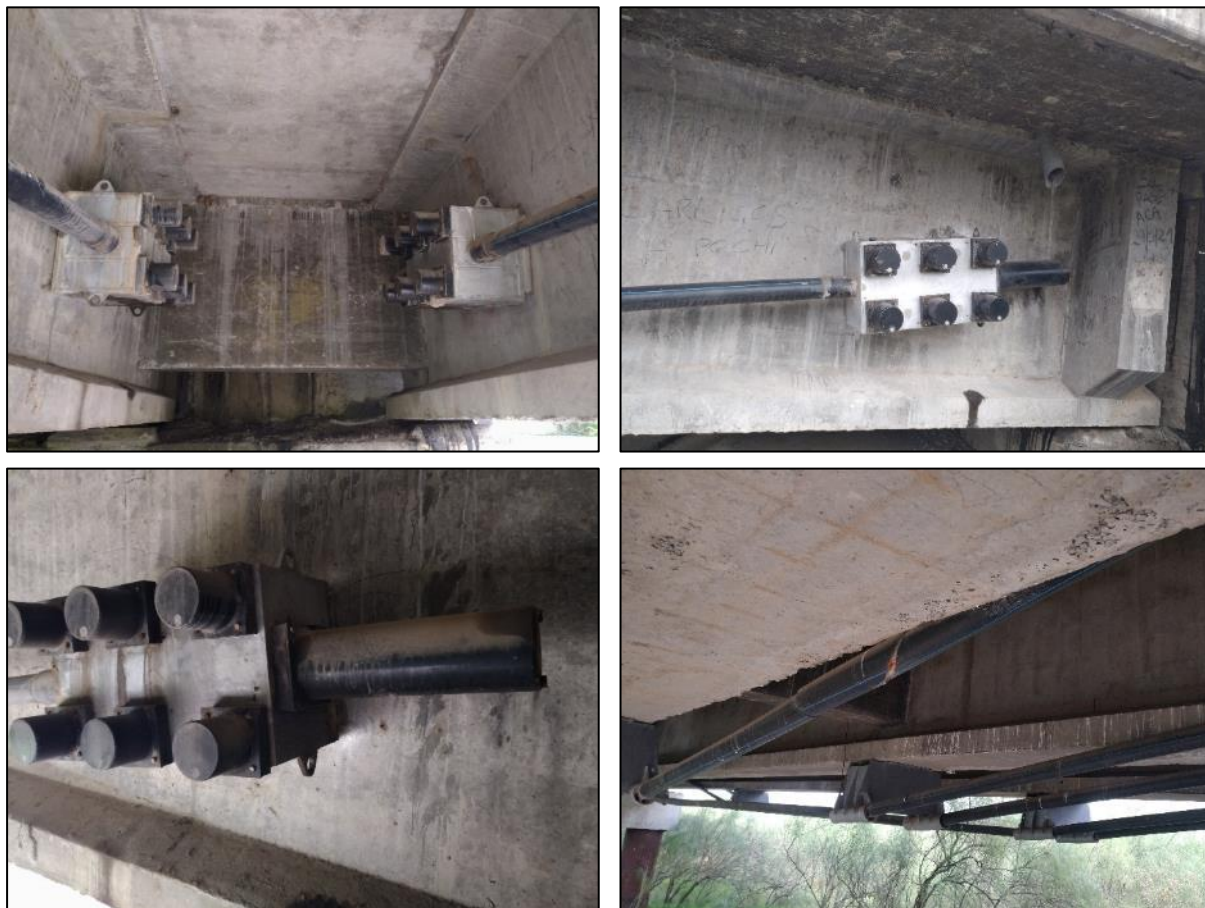
Figura 50 a 53. Estado de desviadores y anclajes
