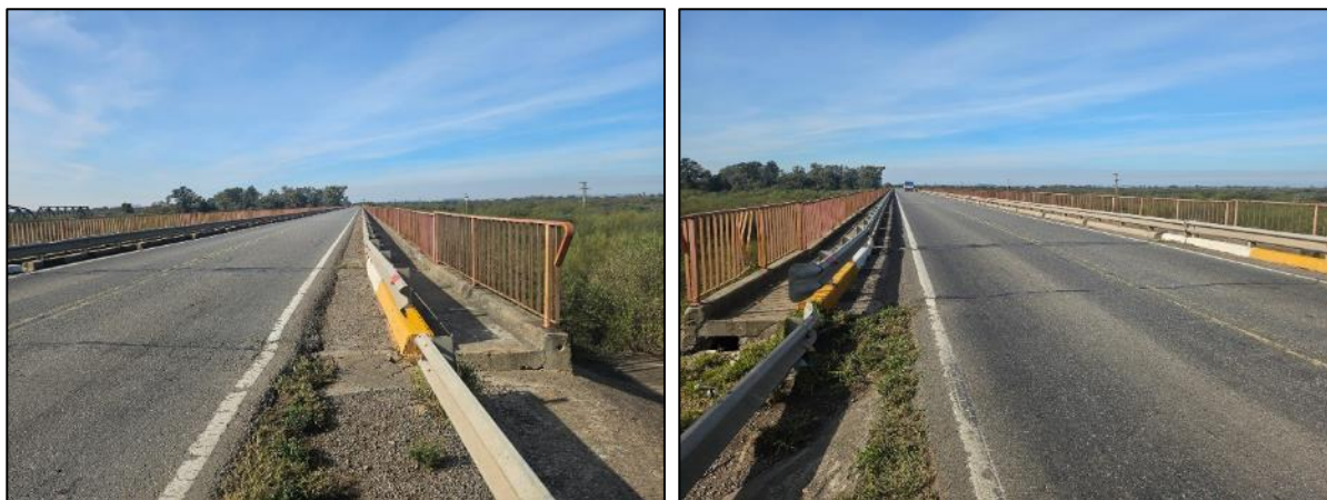
Figura 57 y 58. Vistas de la calzada
