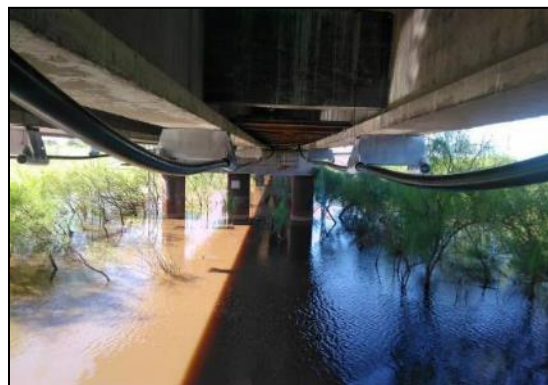
Figura 32. Montaje de vainas de PEAD
