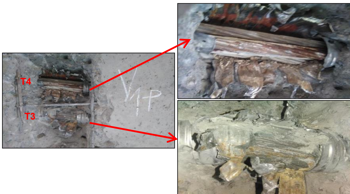
Figura 14. En Viga 1 - Tensores 3 y 4 lado pila
