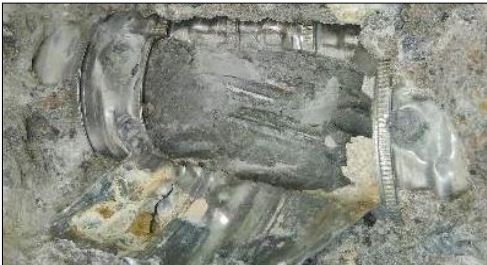
Figura 19. En Viga 1 – Auscultación tensor 2 – centro de tramo
