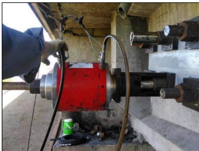
Figura 29. Ajuste por tesado transversal de las barras (Freyssibar FB50) de fijación
