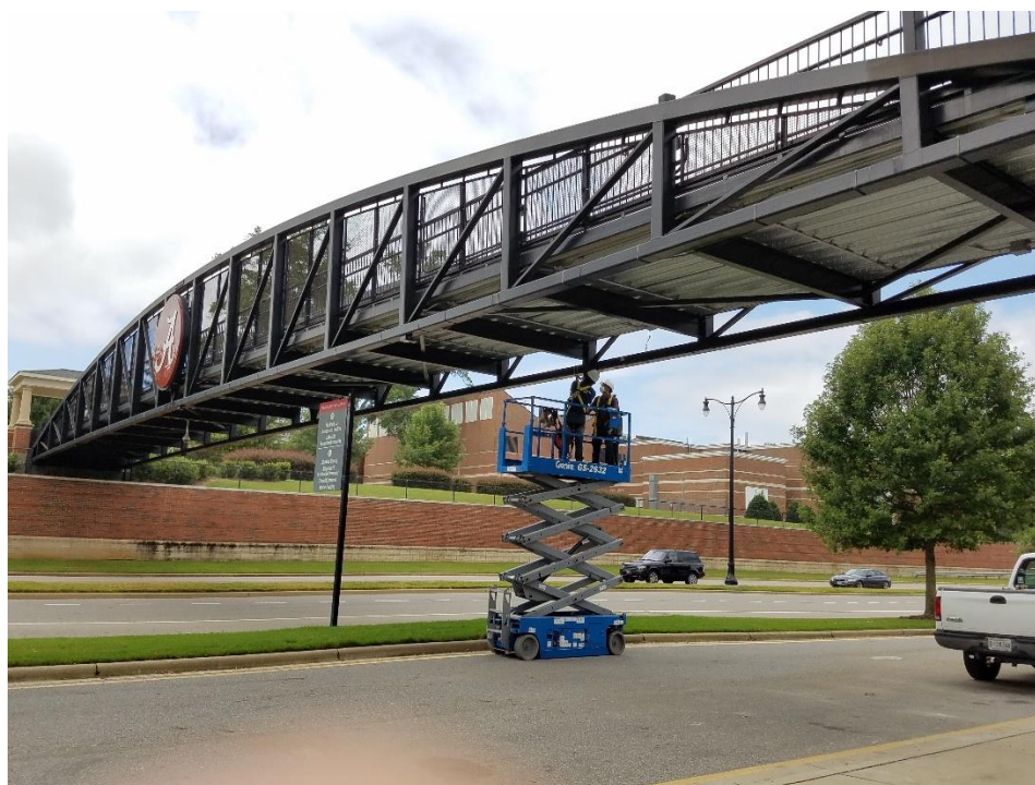
Figura 1. Puente peatonal de Hackberry Lane en Tuscaloosa, Alabama.
