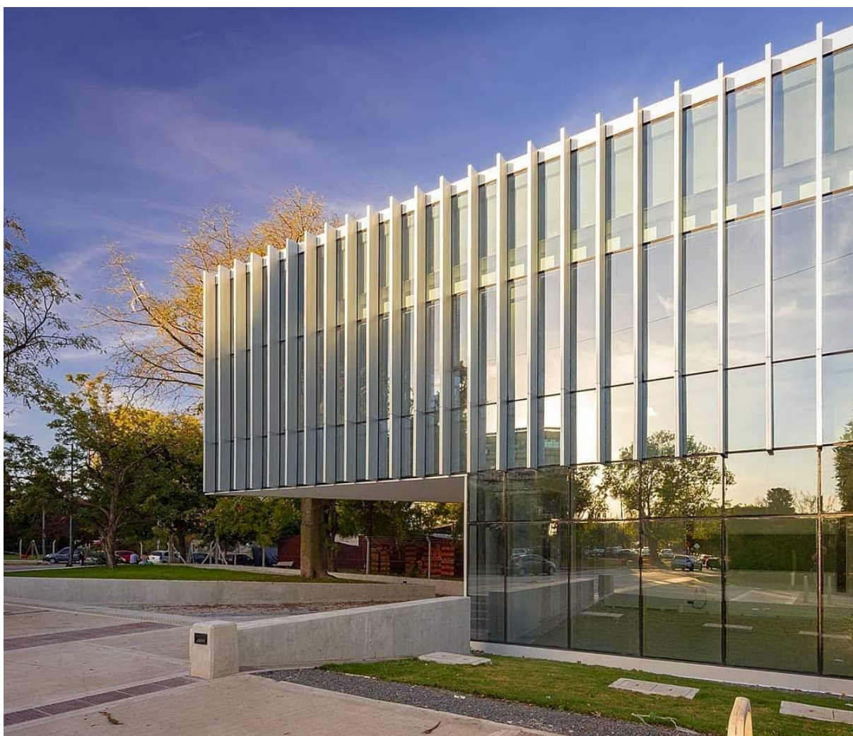
Figura 1 Vista del Sector de la obra
