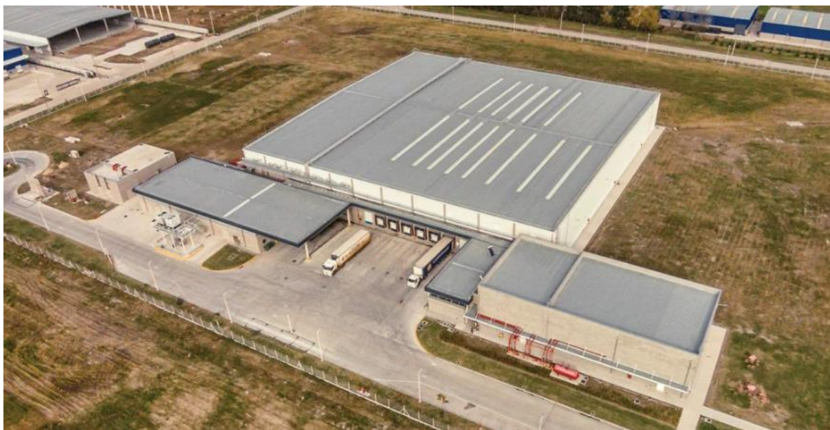
Figura 17 Vista general de la obra
