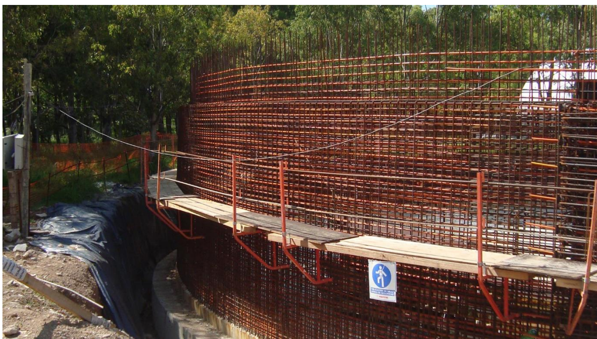
Figura 15 Vista de armado de cables
