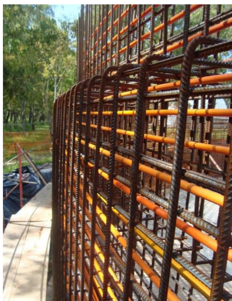
Figura 16 Vista de armado de cables
