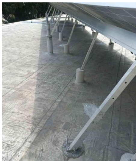
Figura 4: Nuevos anclajes incorporados
