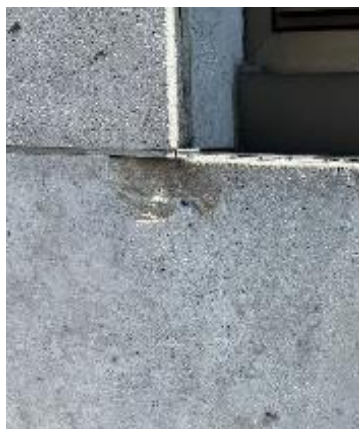
Figura 4. Borde astillado en el proyecto ubicado en región parisina
