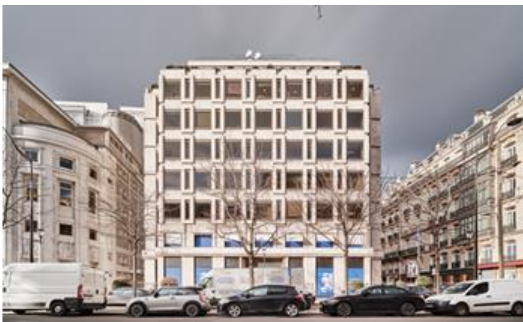
Figura 3. Fachada de edificio a rehabilitar en región parisina
