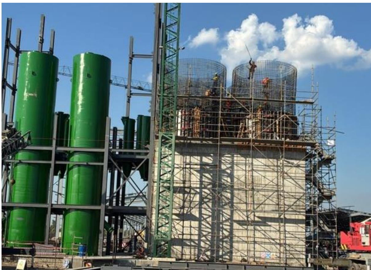
Figura 10: Construcción de los silos de hormigón y de la estructura metálica con los silos de acero colocados.
