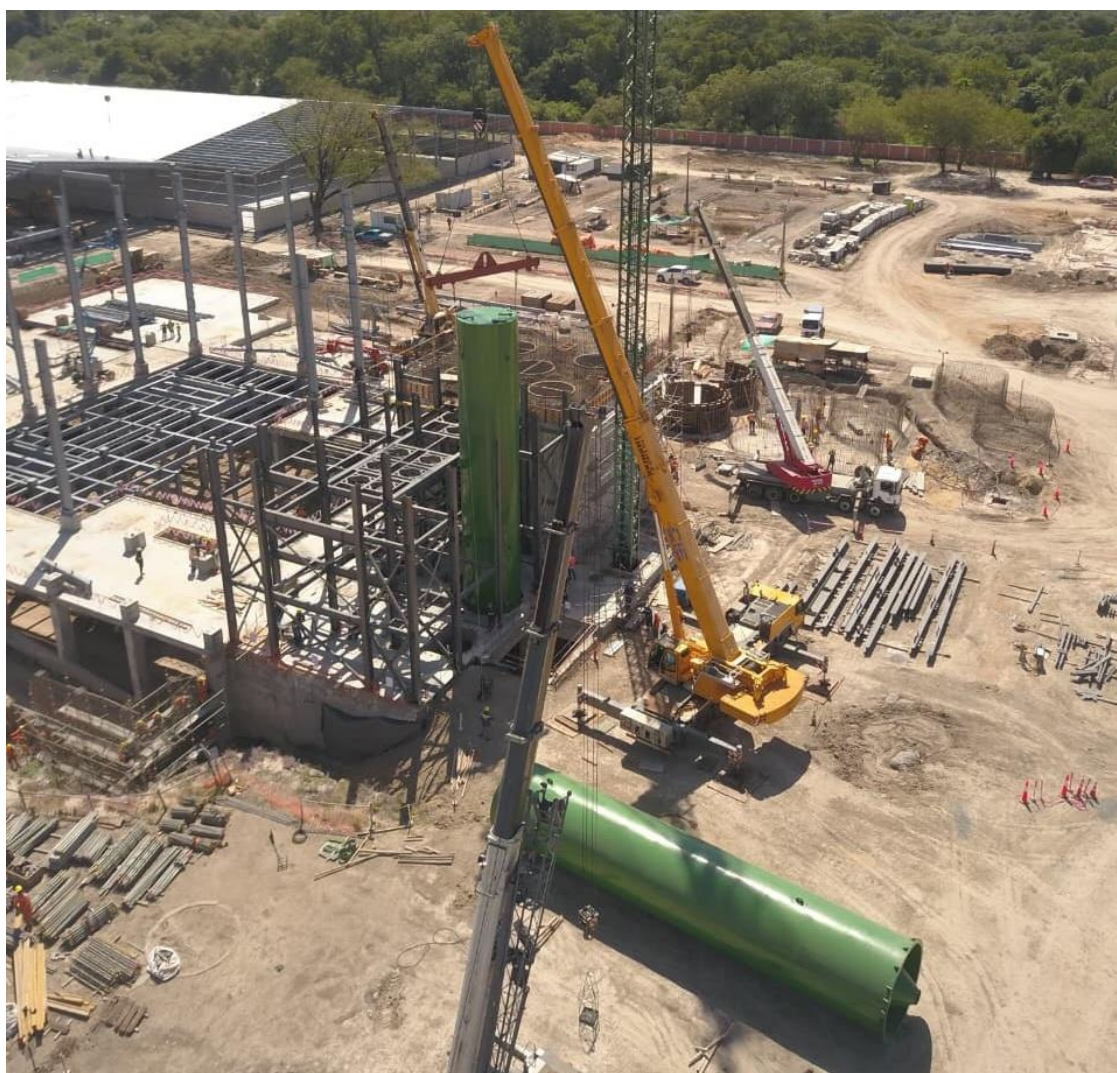
Figura 9: Secuencia de montaje de silos de acero durante la instalación de la estructura metálica.
