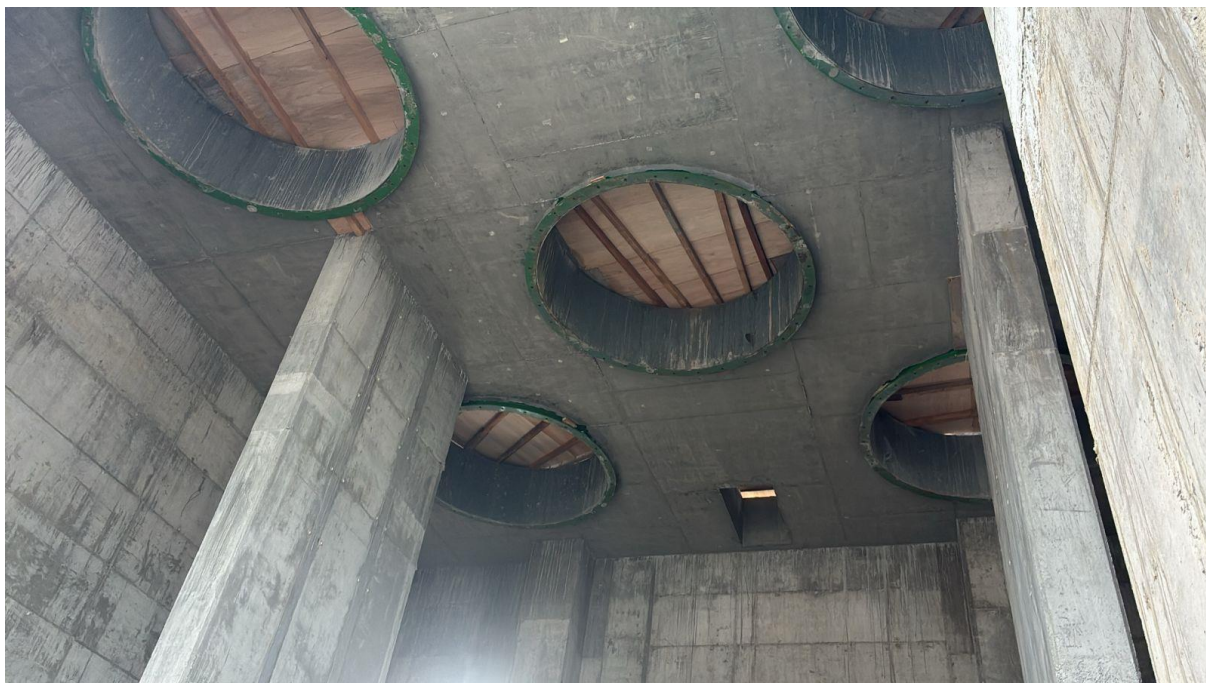
Figura 8: Soporte de las tolvas de los silos metálicos.
