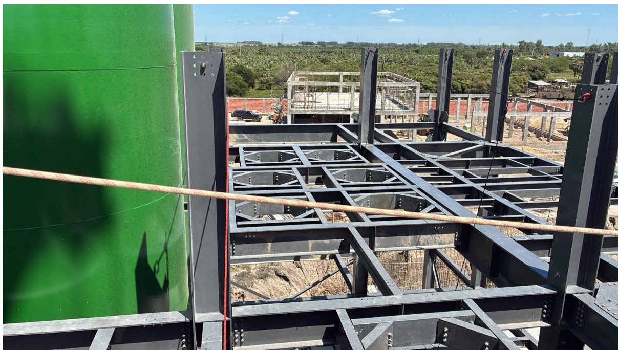
Figura 11: Vista de la construcción del nivel +9.69 m.
