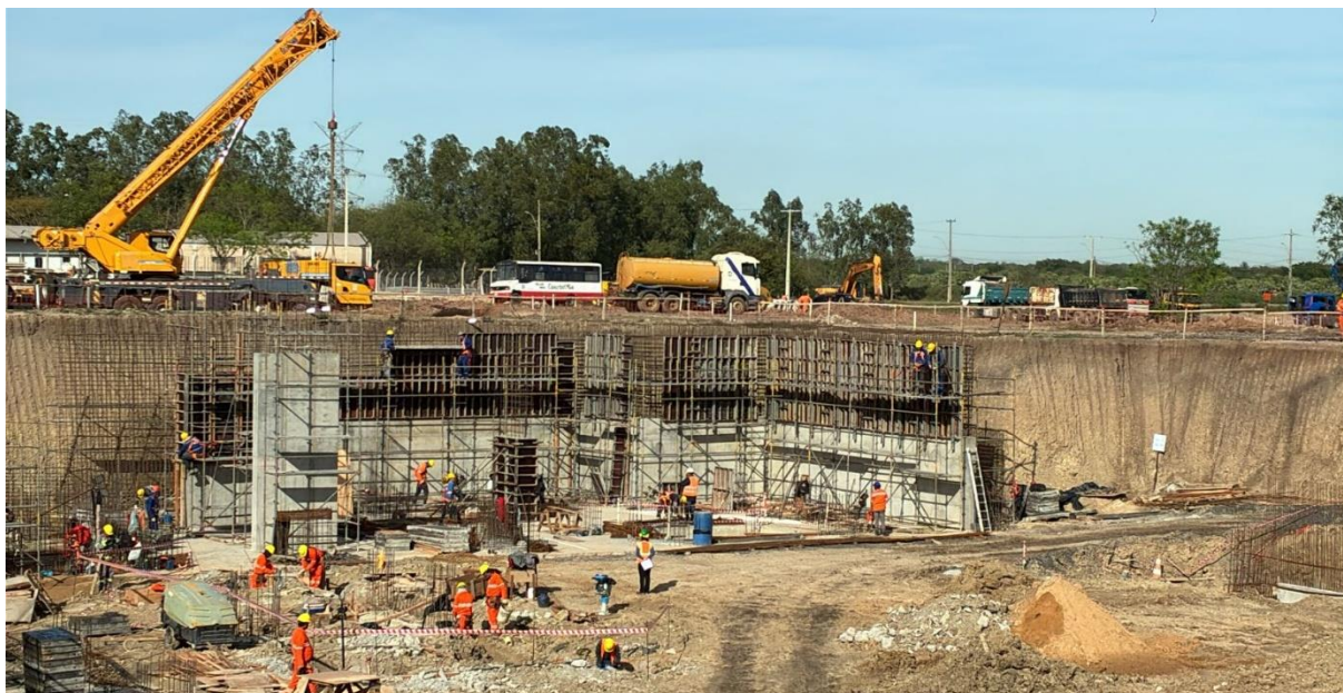
Figura 3: Vista de la obra del subsuelo.
