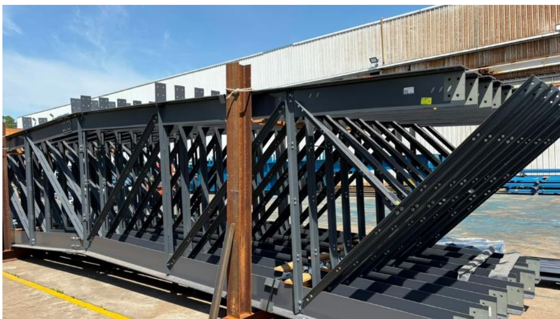
Figura 10. Pre armado en taller de vigas secundarias
