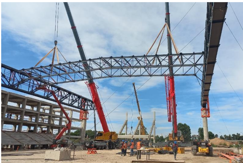
Figura 21. Montaje del primer módulo de cubierta
