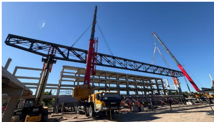
Figura 18. Izaje de la primer viga de apeo mediante dos grúas
