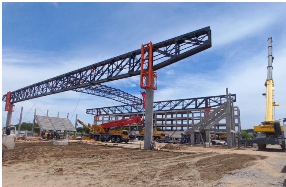
Figura 23. Estado luego de la primer instancia crítica de montaje
