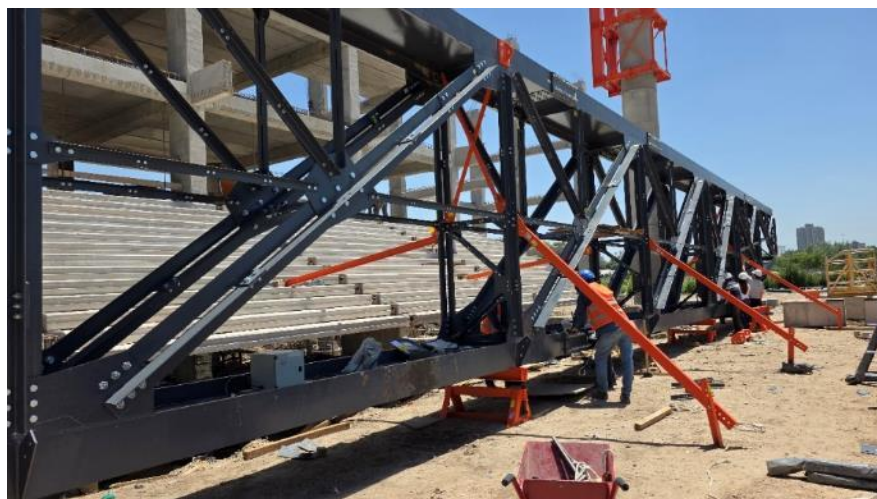
Figura 17. Armado y verticalización de vigas de apeo
