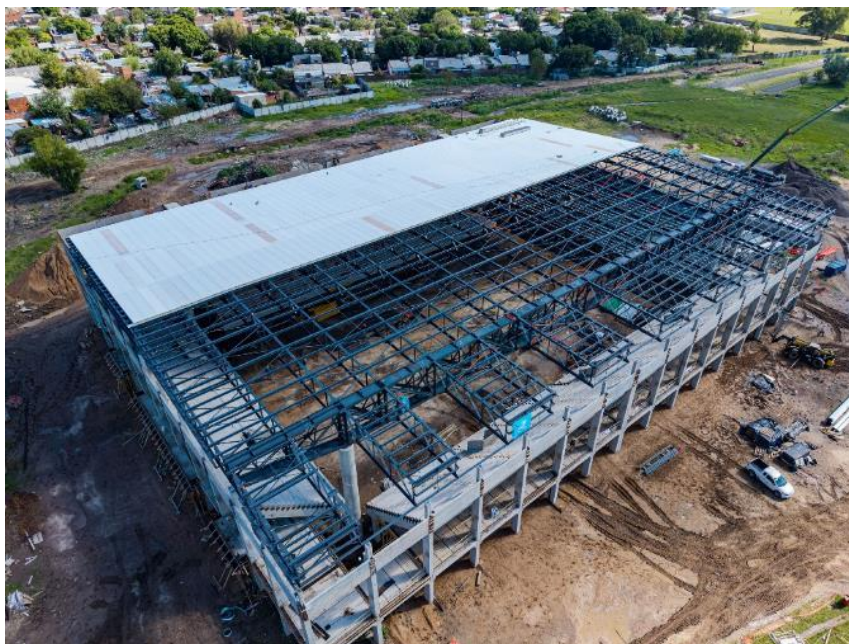
Figura 26. Vista aérea de la estructura de cubierta con avance de paneles de cerramiento
