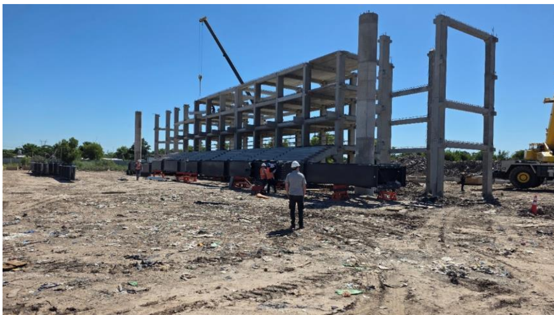
Figura 12: Estado de la obra al momento del comienzo de los trabajos de armado
