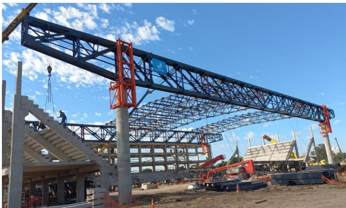
Figura 24. Montaje de módulos 2 y 3 de cubierta
