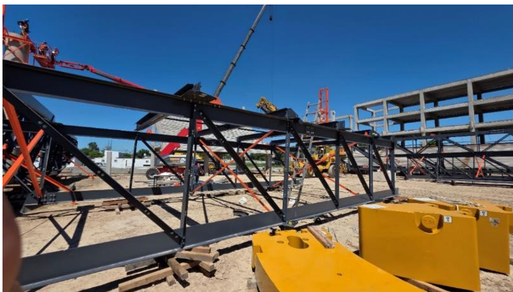
Figura 20. Armado de módulos en obra
