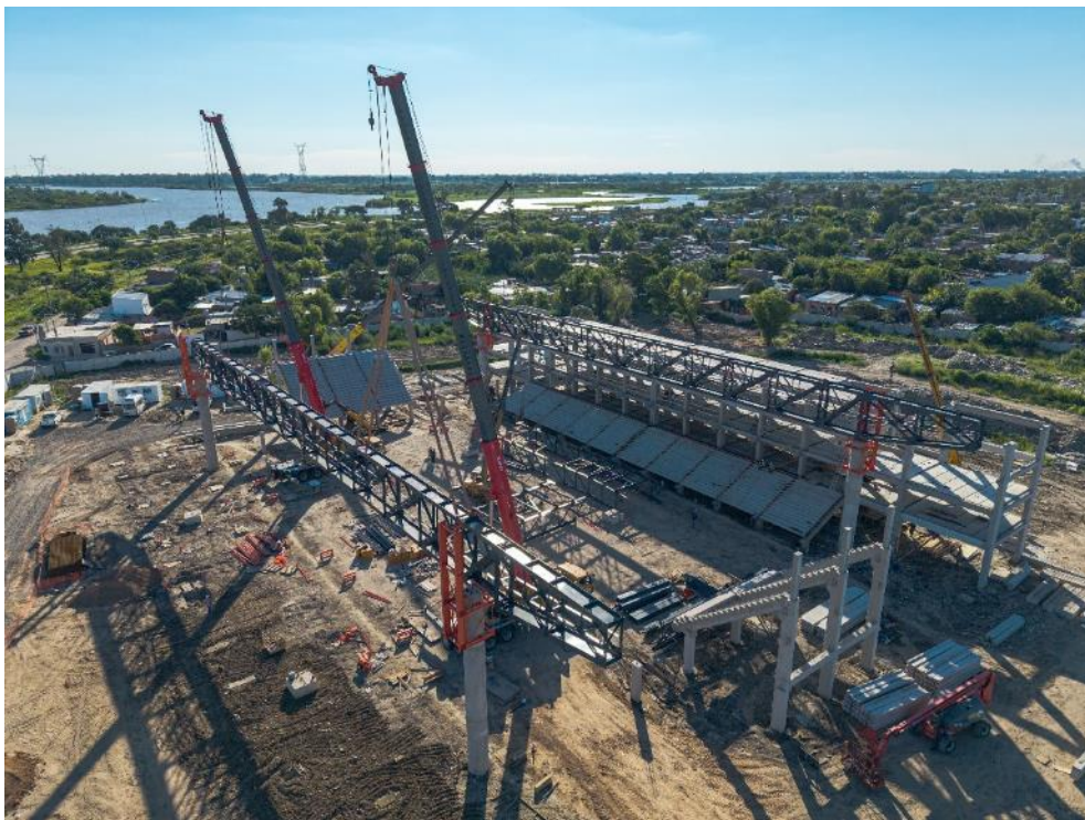
Figura 22: Montaje de segunda viga de apeo
