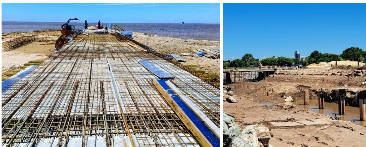
Figura 8: Pasarela pescante con pilas encamisadas, vigas en voladizo y tablero de losetas prefabricadas (izq.); ejecución de pilotes y micropilotes de la defensa (der.).
