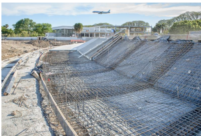
Figura 7: Imágenes de la construcción de tablestacas con viga de coronamiento (izq.); defensa costera de losa sobre vigas (der.).
