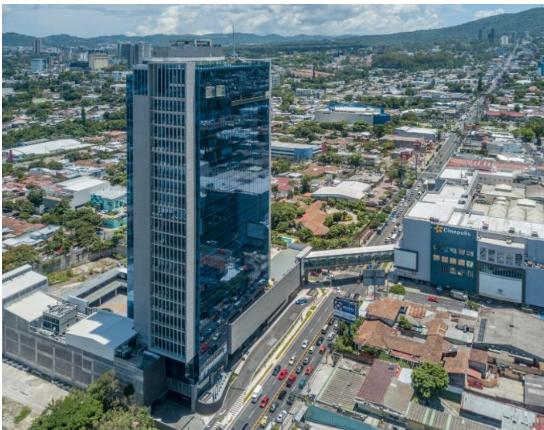
Figura 1. Vistas de edificio, Torre Millennium
