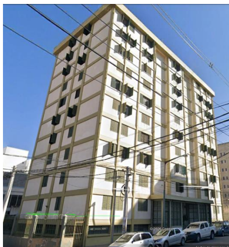
Figura 1. Imagen del edificio en estudio.
