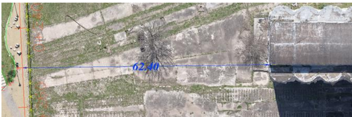
Figura 2. Foto aérea con menor distancia de los silos a la traza del conducto
