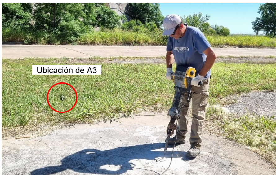
Figura 11: Operario accionando el martillo neumático
