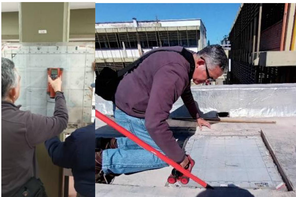
Figura 8. Escaneo de armaduras en columnas y losas
