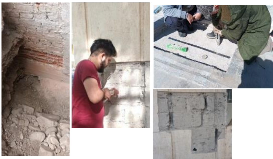
Figura 6. Cateos en fundación, muros y losas
