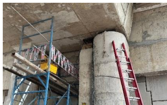
Figura 18. Pila auxiliar en el Eje I
