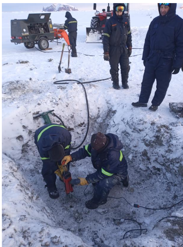
Figura 10. Inserción de la barra de anclaje con el adhesivo químico
