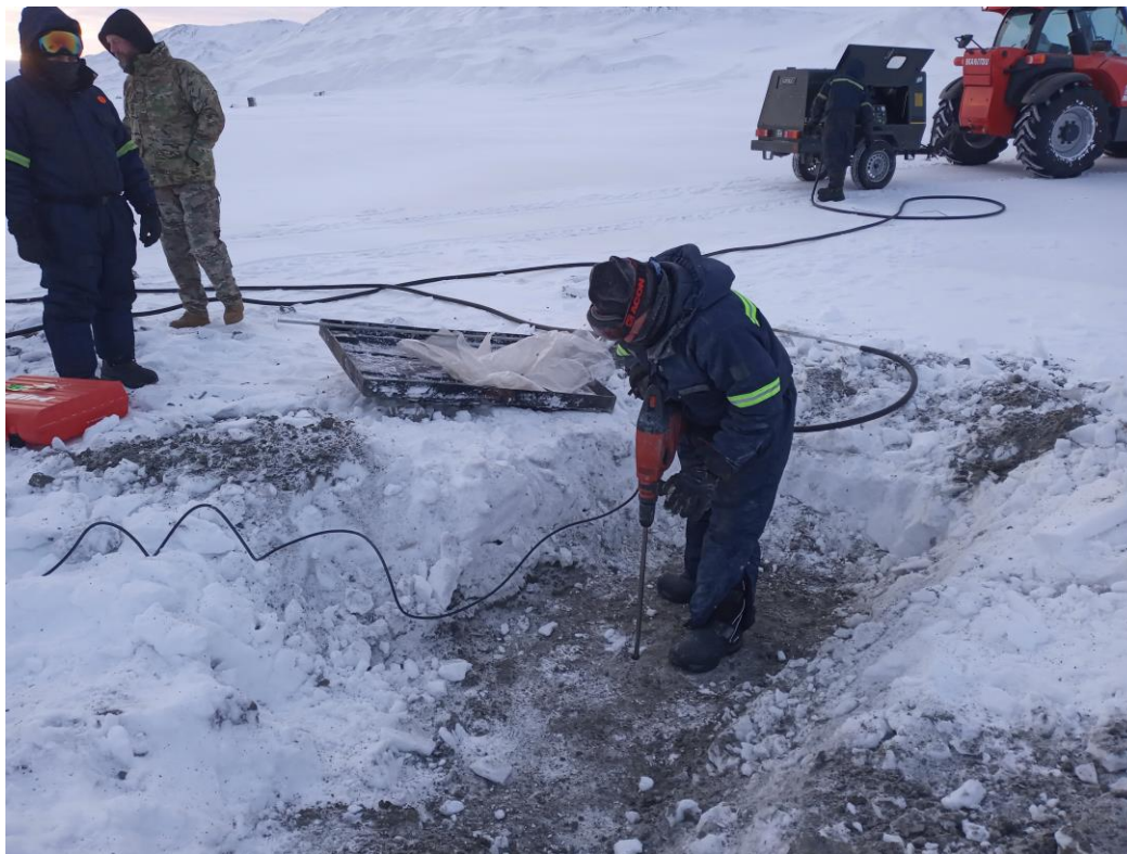
Figura 9. Perforación mediante taladro rotativo
