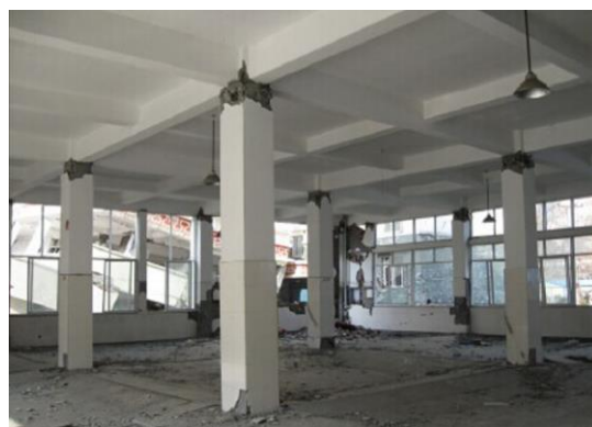
Figura 1. Daños en terremotos recientes. Izq. Falla de piso por viga fuerte columna débil (Duzce 1999 earthquake damage). Der. Plastificación de extremos de columnas (Ning, et al, 2017).
