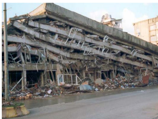
Figura 1. Daños en terremotos recientes. Izq. Falla de piso por viga fuerte columna débil (Duzce 1999 earthquake damage). Der. Plastificación de extremos de columnas (Ning, et al, 2017).
