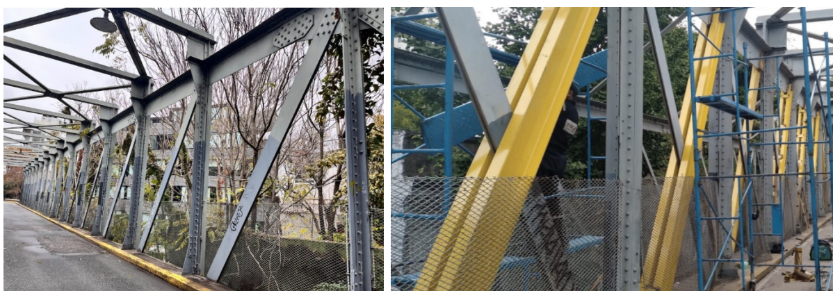
Figura 13. Casos de éxito de rehabilitación de puentes de acero existentes en la CABA. Puente Ciudad de la Paz (2025).
