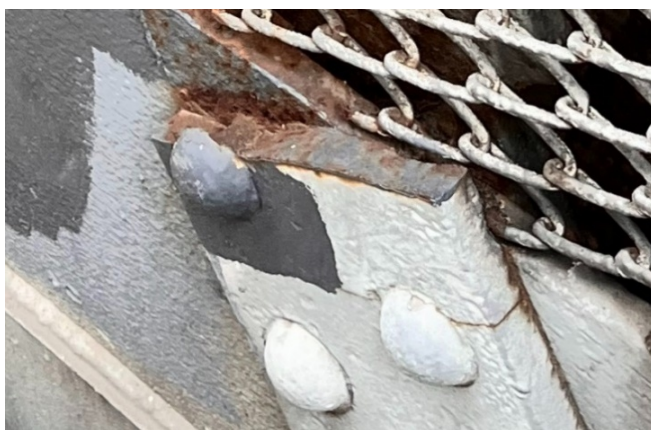
Figura 2. Puente Ciudad de la Paz, CABA (inaug. 1913). Diagonal original fracturada
